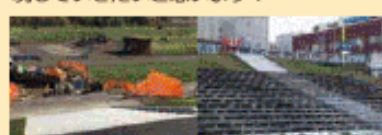
豊平川河川敷パークゴルフ場階段設置
